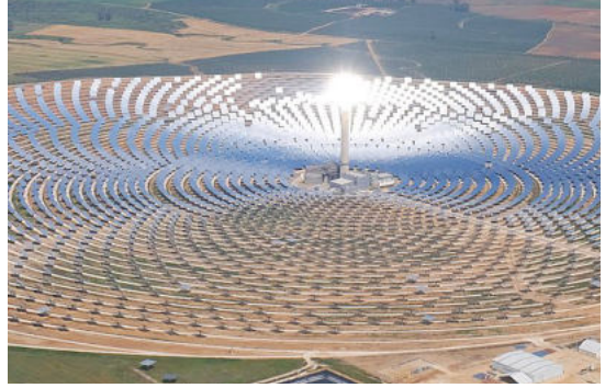
(ক) সৌর প্যানেল। (খ) স্পেনে অবস্থিত সৌরশক্তি টাওয়ার বা সোলার কনসেন্ট্রেটর। এখানে বাঁকানো আয়না ব্যবহার করে সূর্যের তাপশক্তি ঘনীভূত করে কাজে লাগানো হয়।
