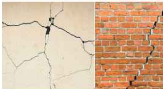
চিত্র: দেওয়ালের প্রাস্টারে ফাটল
