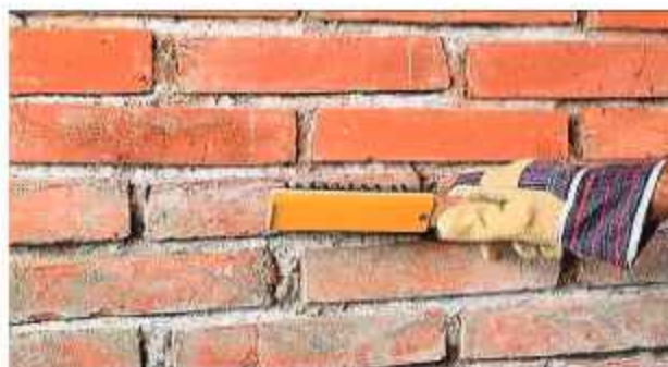
চিত্র: ১.৩১ দেওয়ালে শেওলা থাকলে তা ভালভাবে পরিষ্কার করা
