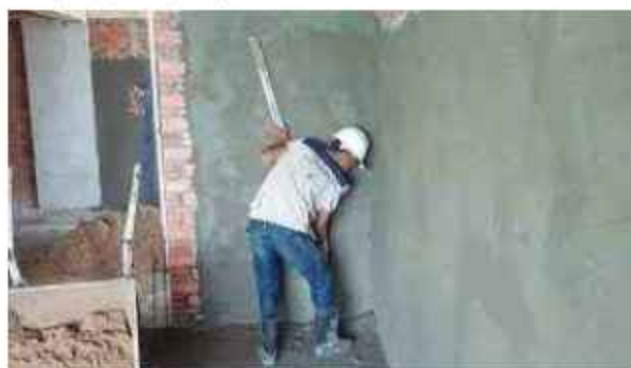
চিত্র: ৩.২১ পাট্টার সাহায্যে প্লাস্টার সমতলকরণ
