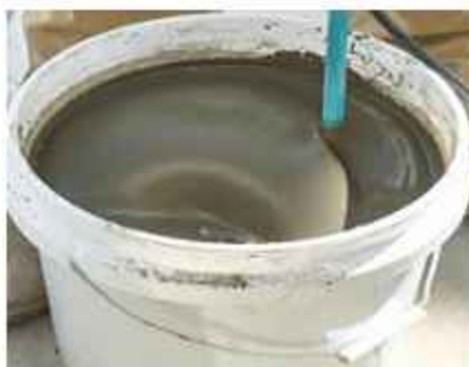
চিত্র: ৩.৩২ প্রস্তুতকৃত গ্রাউটিং ভালোভাবে মেশাই
