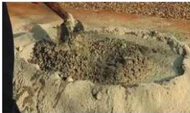
চিত্র ১.৫৩: মসলা তৈরিকরণ
