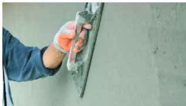
চিত্র ১.৪২: প্লাস্টারিং কাজে পাট্টার ব্যবহার
