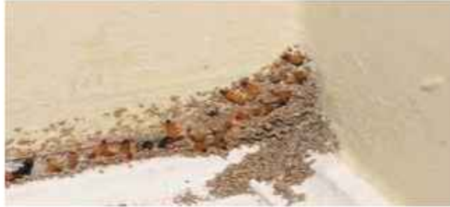
চিত্র : ফ্লোরে উইপোকোর আক্রমণ
