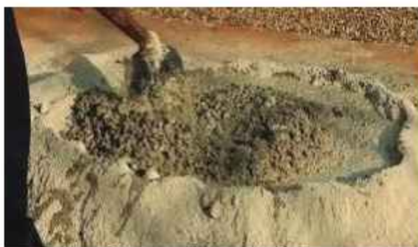
চিত্র ১.৪৮: মসলা তৈরিকরণ
