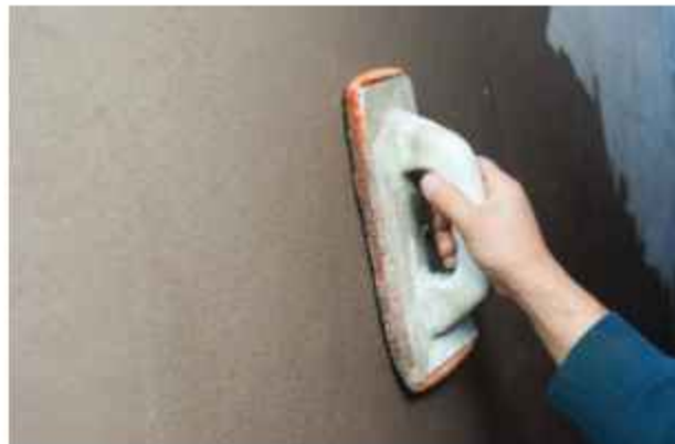
চিত্র: ১.৪০ প্লাস্টারিং কাজে উষার ব্যবহার
