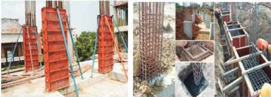
চিত্র ৪.৫৭: সাটারিং বা ফর্মওয়ার্ক তৈরি
