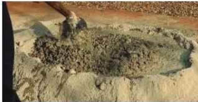
চিত্র ২.২২: মসলা তৈরিকরণ
