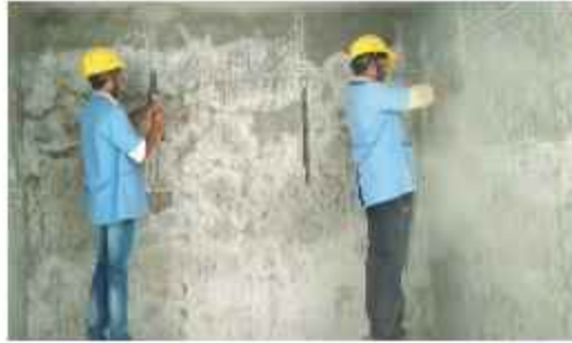
চিত্র ১.৫৫: আরসিসি সারফেস চিপিংকরণ
