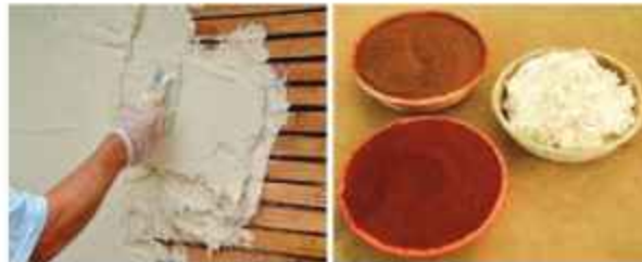
চিত্র: ১.৬ লাইম প্লাস্টার
