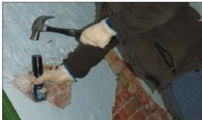
চিত্র: ২.২৩ ত্রুটিপূর্ণ প্লাস্টার
