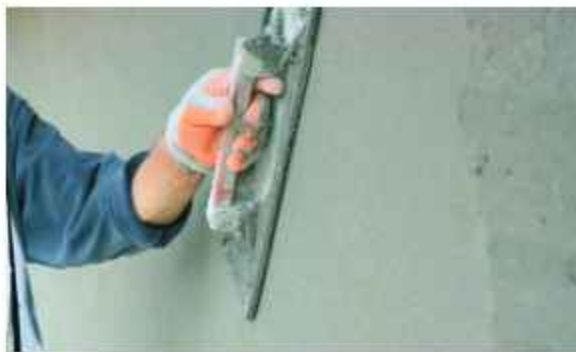
চিত্র ১.৪৪: প্লাস্টারিং কাজে উষার ব্যবহার
