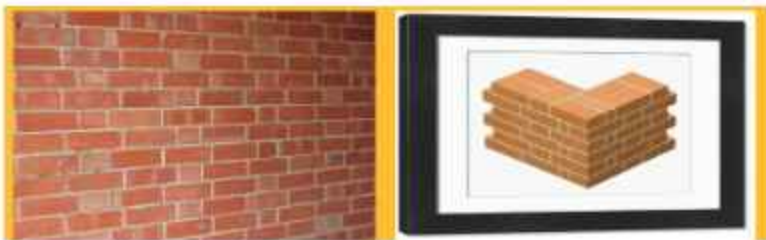
চিত্র ৩.১০ : ফ্রেমিশ গার্ডেন ওয়াল বন্ড
