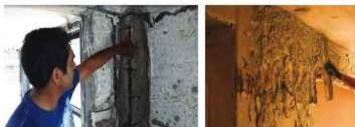
চিত্র: ৩.১২ পুরাতন নষ্ট প্লাস্টার তুলে ফেলা হচ্ছে
