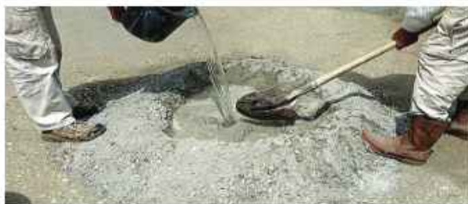
চিত্র ২.২০ : ১:৪ অনুপাতে সিমেন্ট বালির মসলা তৈরি
