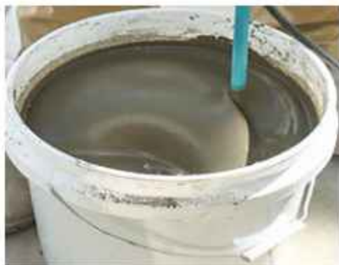
চিত্র: ৩.৩১ গ্রাউন্ডিং তৈরি
