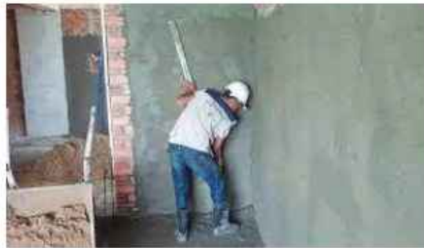
চিত্র: ১.৪০ প্লাস্টারিং কাজে পাট্টার ব্যবহার
