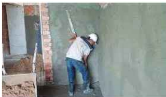
চিত্র: ১.৩৮ পাট্টা ব্যবহার করে পুরো পৃষ্ঠতল মসৃণ করা
