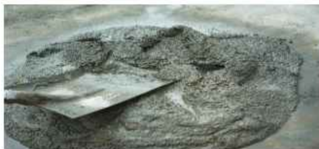
চিত্র : ১.১৮ মসলা তৈরিকরণ
