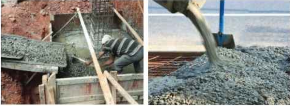
চিত্র-৪.৯: কংক্রিট স্থাপনের ফর্ম
