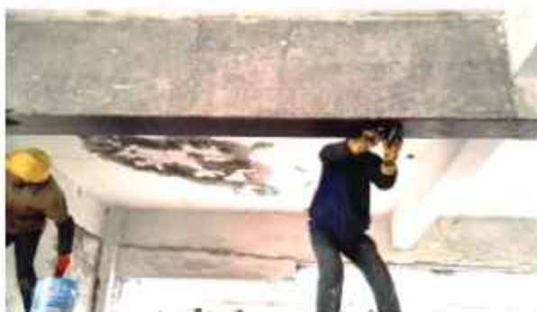
চিত্র : ৩.১০ তৈলাক্ত পদার্থ, শ্যাওলা বা অবাস্তিত পদার্থ ব্রাশ দিয়ে পরিষ্কার করা
