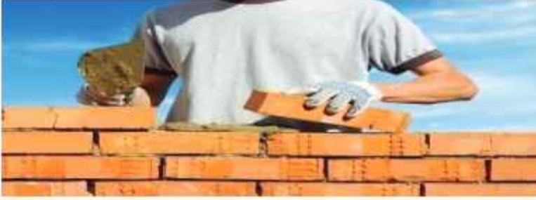
চিত্র ৩.৫২ : স্ট্রেচার বন্ডে ইটের গাঁথুনি
