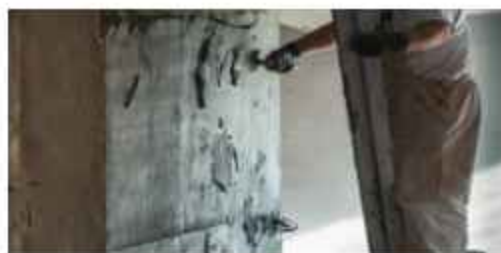
চিত্র: ৩.১৩ দেওয়াল প্লাস্টারকরণ
